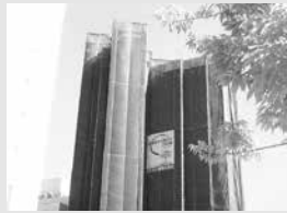
大規模修繕工事
