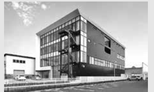
静和ケミカルサービス(株)本社社屋
