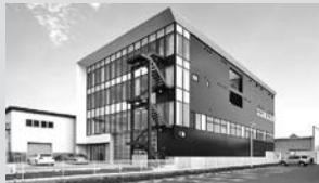
静和エンバイロメント(株)本社社屋
