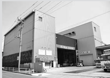
エコプラント江東外観
